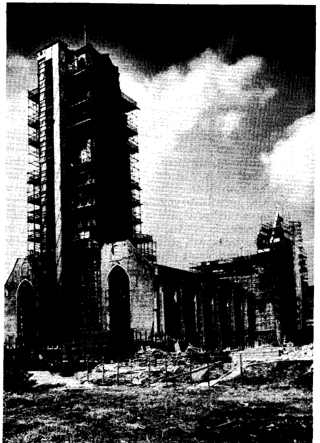
De restauratie van de St. Laurenskerk te Rotterdam.
