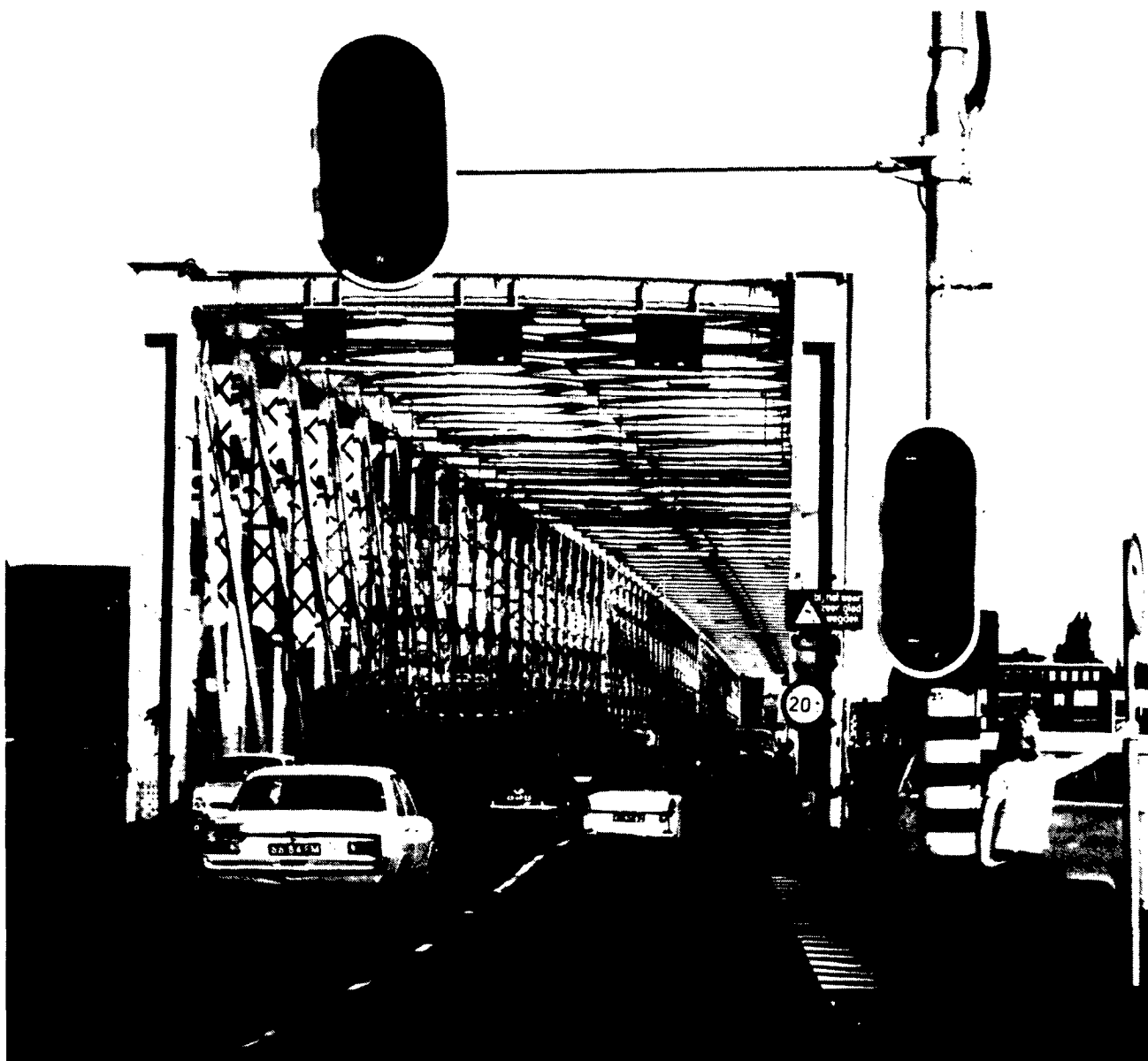
Willemsbrug zoekt vervanger
