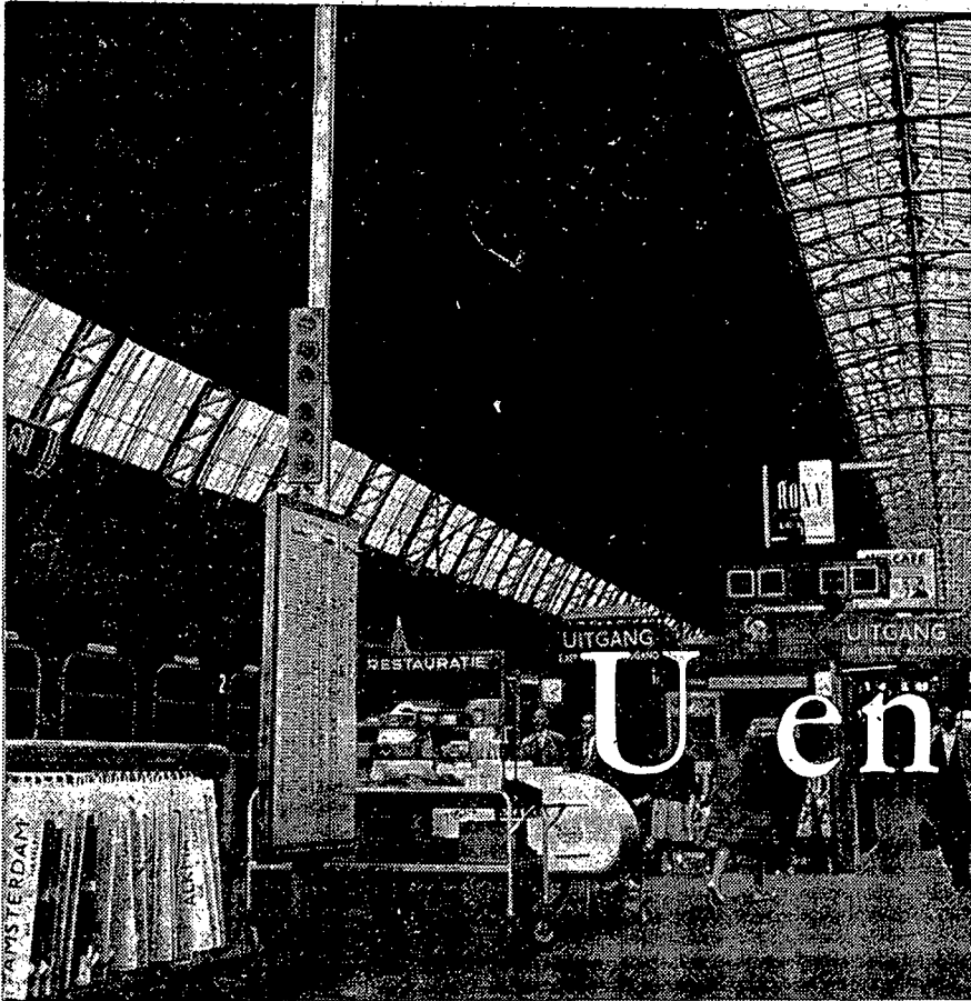
Geluidsinstallatie Centraal Station Amsterdam. In samenwerking met Nederlandse Spoorwegen en PTT werd met een speciale schakeling het geluid op dit station zodanig geregeld, dat een uitstekende verstaanbaarheid over alle perrons werd verkregen.
