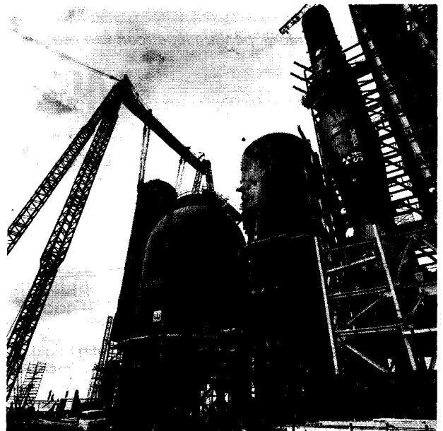
Flexicoker in aanbouw op de Esso Raffinaderij: een procesinnovatie in een 'rijpe' sector (foto Exxon)
