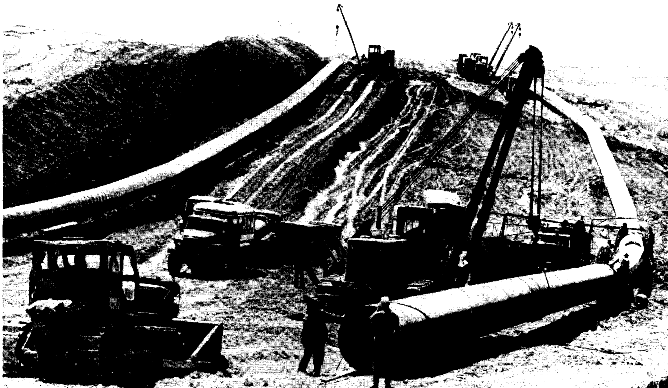
De aanleg van de pijpleiding waardoor de Sovjetunie nauwer met olie van West-Europa wordt verbonden
