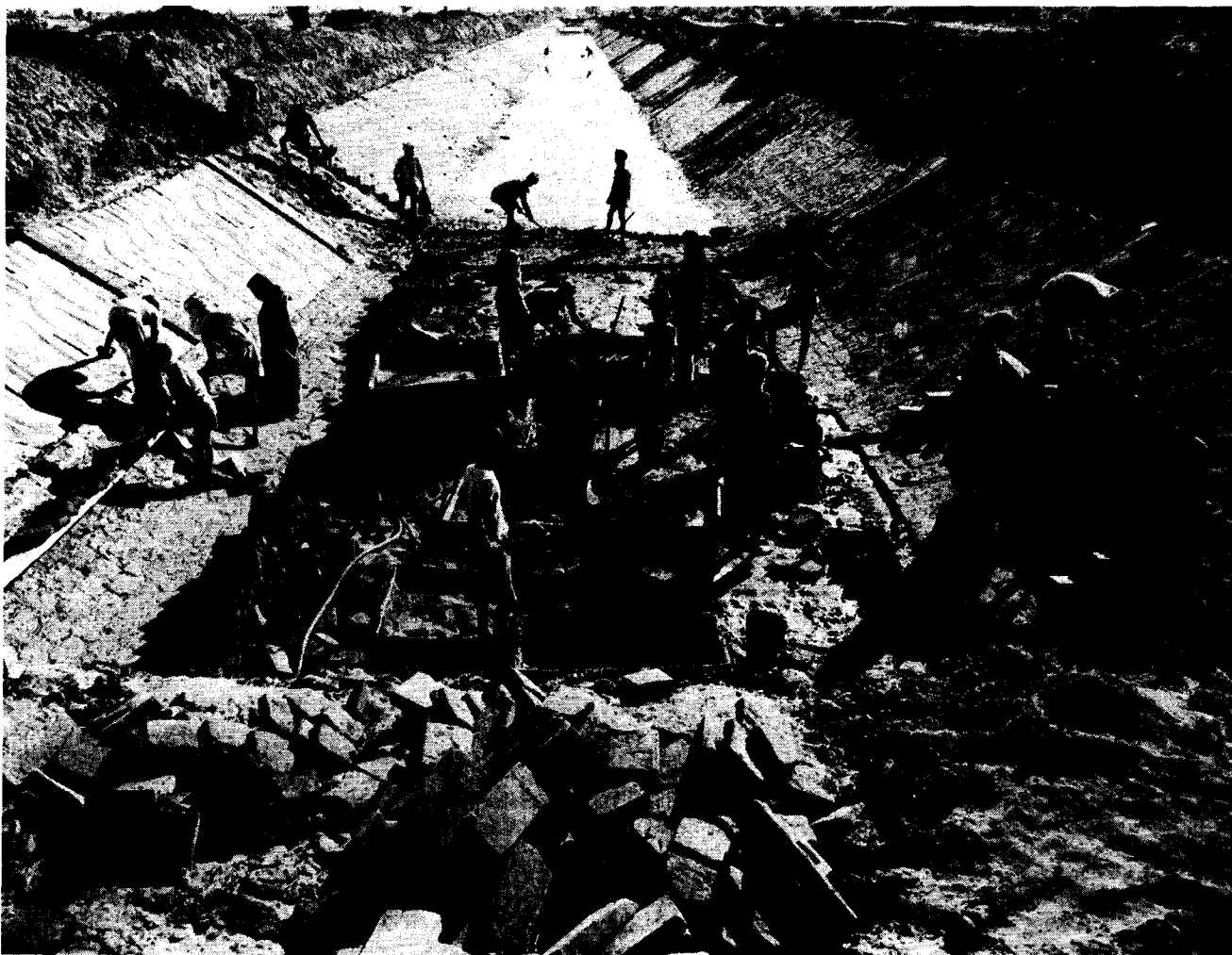
Kanaalaanleg in Rajasthan, India, in het kader van een irrigatieproject, medegefinancierd door de Wereldbank.
